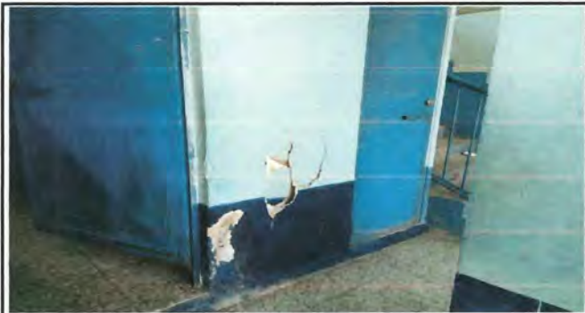
Foto 9: Reparación de paredes
