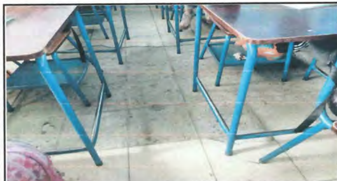
Foto 3: Sustitución de piso cerámico en módulos afectados.
