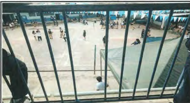
Foto 7: Reparación de Barandas
