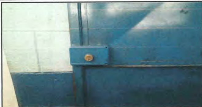
Foto 1: Instalación de nuevas chapas Yale.
