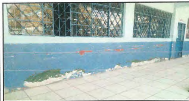
Foto 5: Mantenimiento de balcones de metal.
